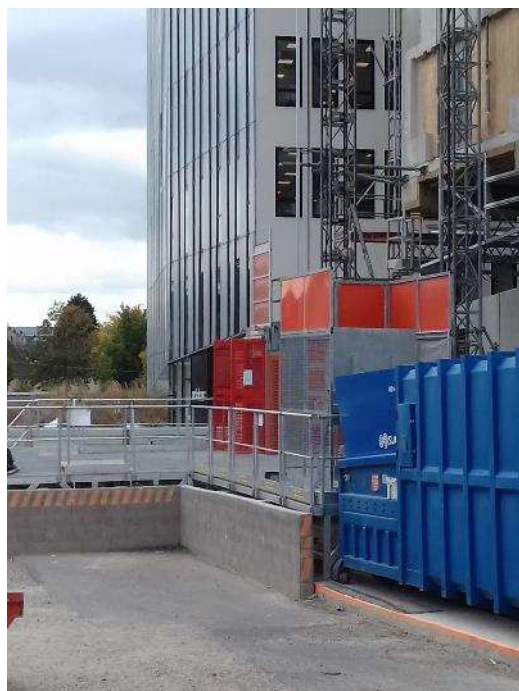
Aire de livraison et stockage DHOL
